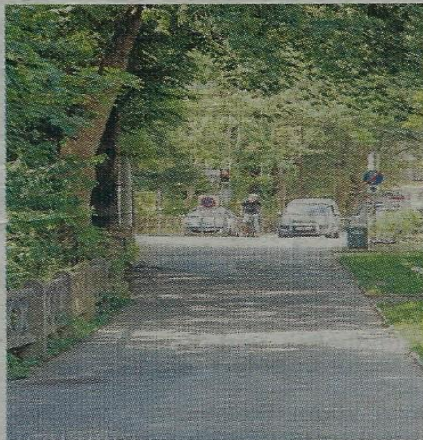
Hier soll die Trasse beginnen: Grundstücke sind noch abzulösen.
